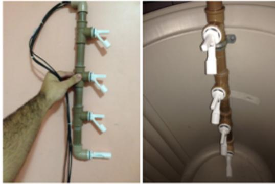
Figura 52 – Sensores de nível posicionados antes da instalação no tanque (esq.) e após a instalação (dir.).
